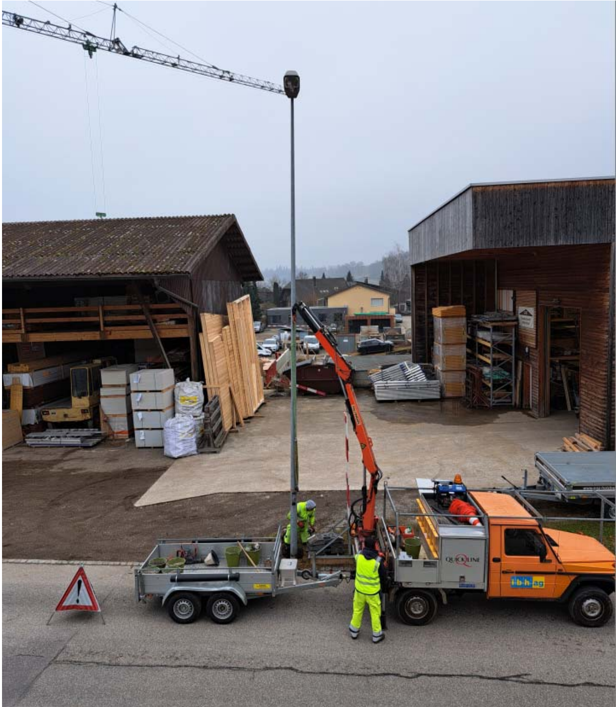
Versetzen Kandelaber an der Industriestrasse
