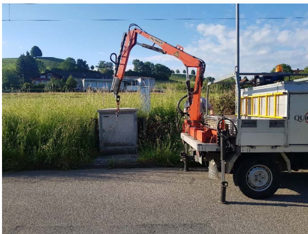
Schachtabdeckung öffnen VK Roggenweg für Glasfaserarbeiten
